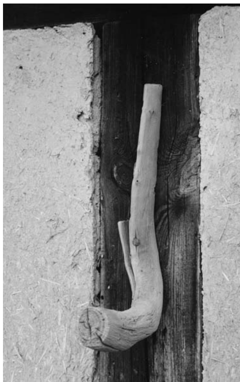
Links: Holzhaken zum Aufhängen der Pferdenachgeburt unter der hofseitigen Traufe der Fachwerkscheune auf dem Hof Teichgasse 6 in Linthe, 2002. Foto: W. Beelitz
